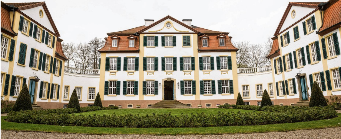
Weitgehend abgeschlossen liegt das Anwesen inmitten von weitläufigen Feldern in Lübbecke. Der Kaufpreis für das Schloss liegt bei 6,4 Millionen Euro – die Kosten für die Instandhaltung noch nicht eingerechnet.
